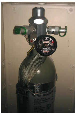
Рис. 52. Пусковой клапан на баллоне с CO 2
